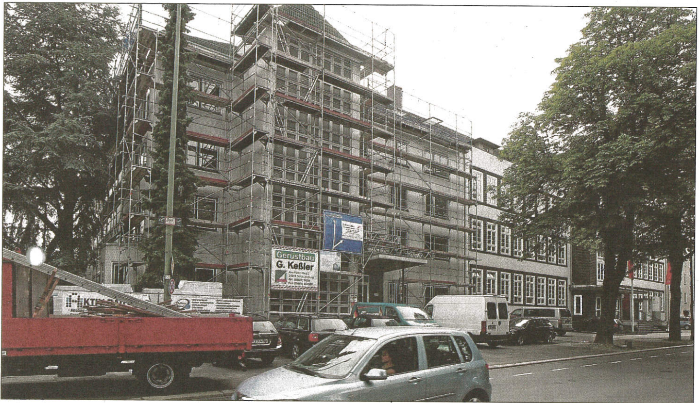
Aufwendiger Umbau: Das Haus Kölnische Straße 71 wird bis zum Frühjahr 2011 komplett umgebaut und saniert.
